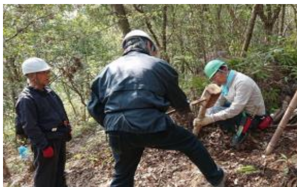
伐採した竹をノコで切りそろえ、杭打ちをし散策路用柵を作る
