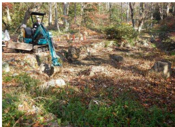
土砂を取り除く作業
